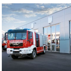
Casernes de pompiers
